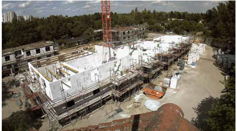
Webcam-Ansicht unserer Baustelle Anfang Juli
