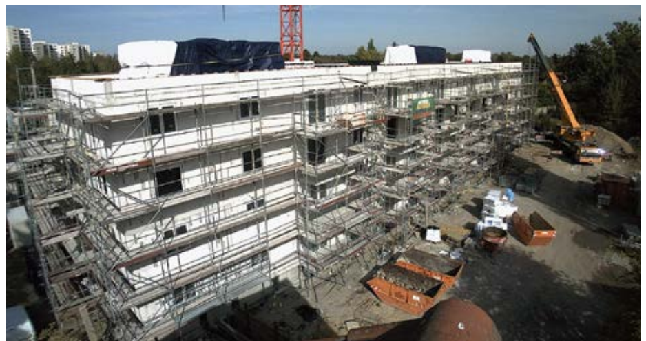
Webcam-Ansicht unserer Baustelle im September
