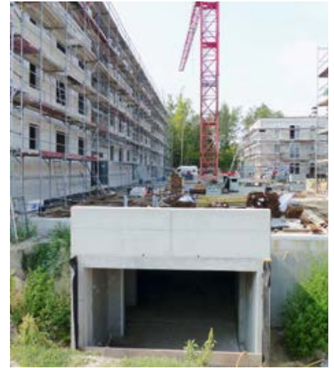
... unserer Baustelle aus.
