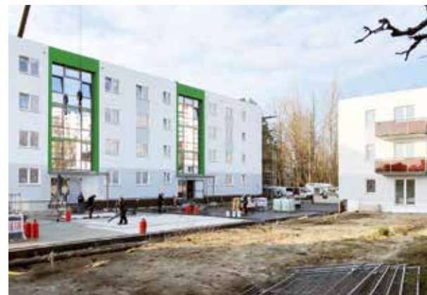
Ansicht unserer Baustelle im März
