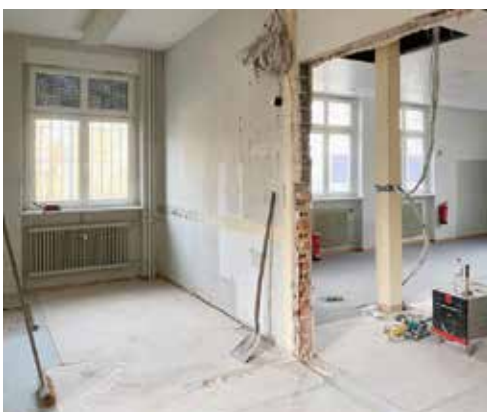
Bauarbeiten in den neuen Räumen
