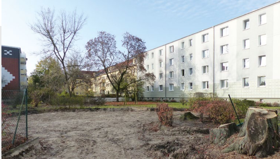
Das Baugrundstück wird vorbereitet.
