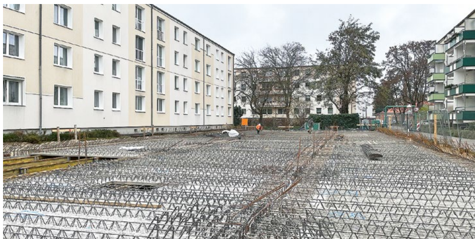
Rohbauansicht der Tiefgarage in der Rolandstraße 98 - 99
