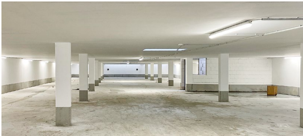
Tiefgarage in der Rolandstraße 98 - 99
