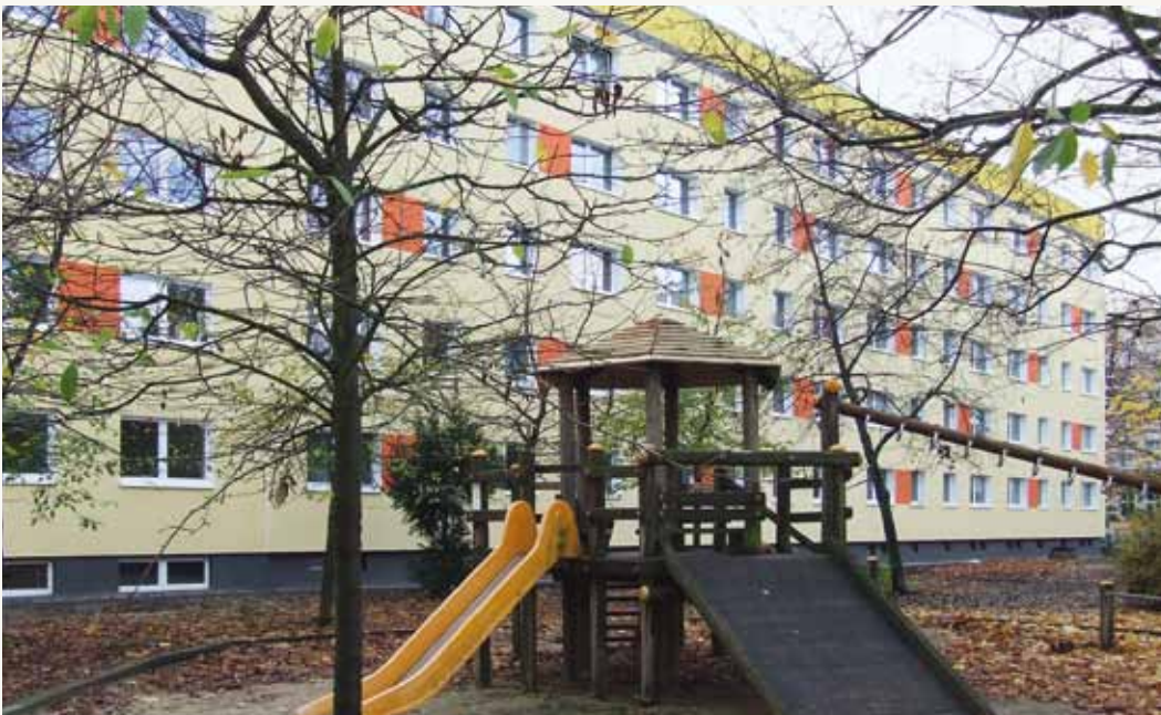
Hofansicht: Der Neubau schließt nahtlos an
