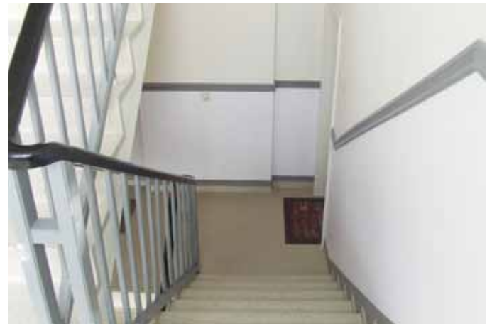
Treppenhausrenovierung in der Rolandstraße
