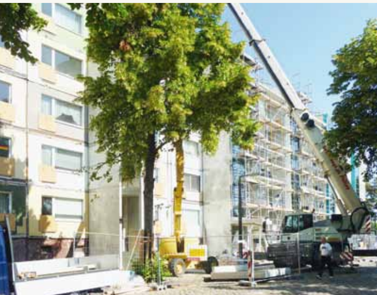
Das Treppenhaus wird entkernt
