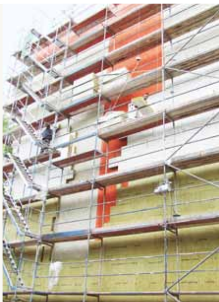
Dämmung des Giebels
