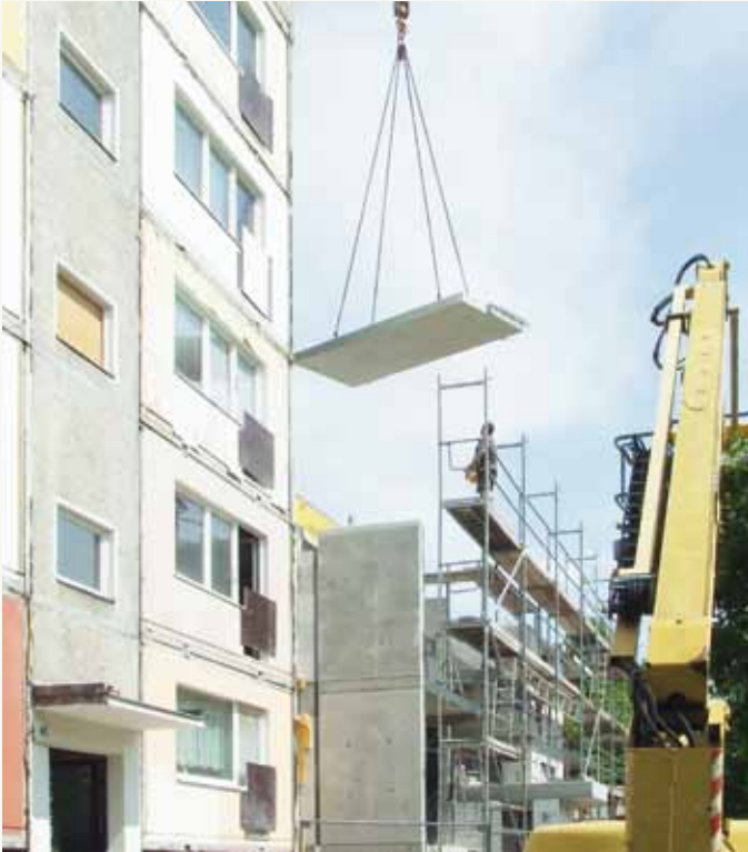
Die Betonplatten für den Neubau schweben an
