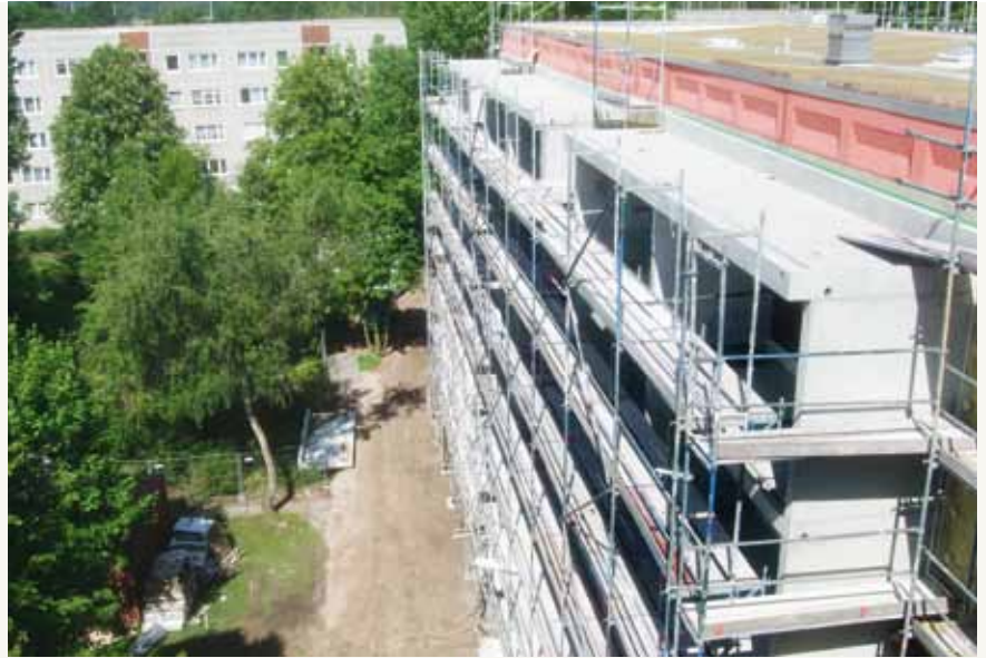
Anbau der neuen Balkone
