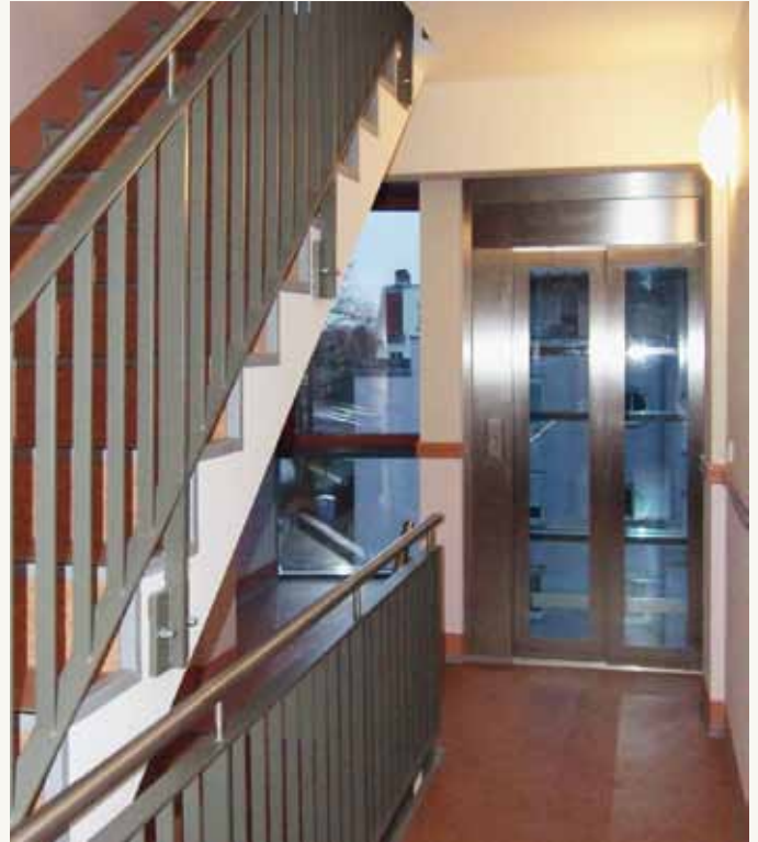
Neues Treppenhaus mit Aufzug
