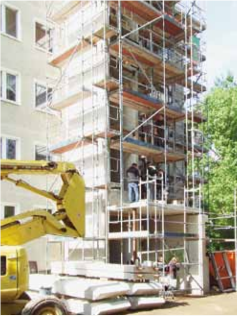
Anbau für den Aufzug
