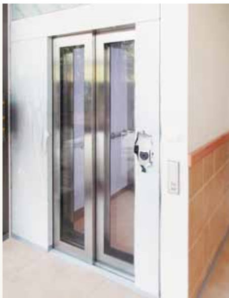
Einbau der Aufzüge
