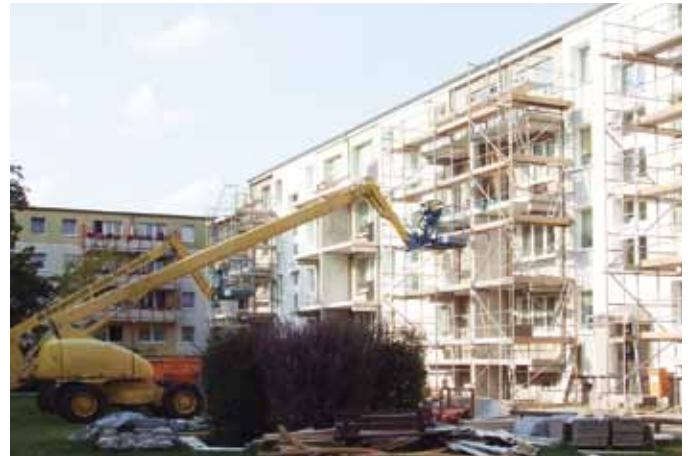
Balkonerneuerung in der Rolandstraße
